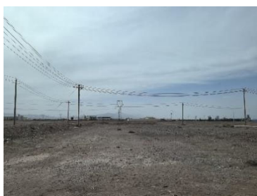
园艺 110kV 变电站西北侧
